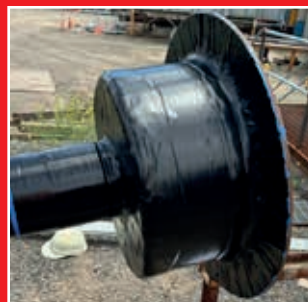
6. Denso PVC Tape overwrap.
