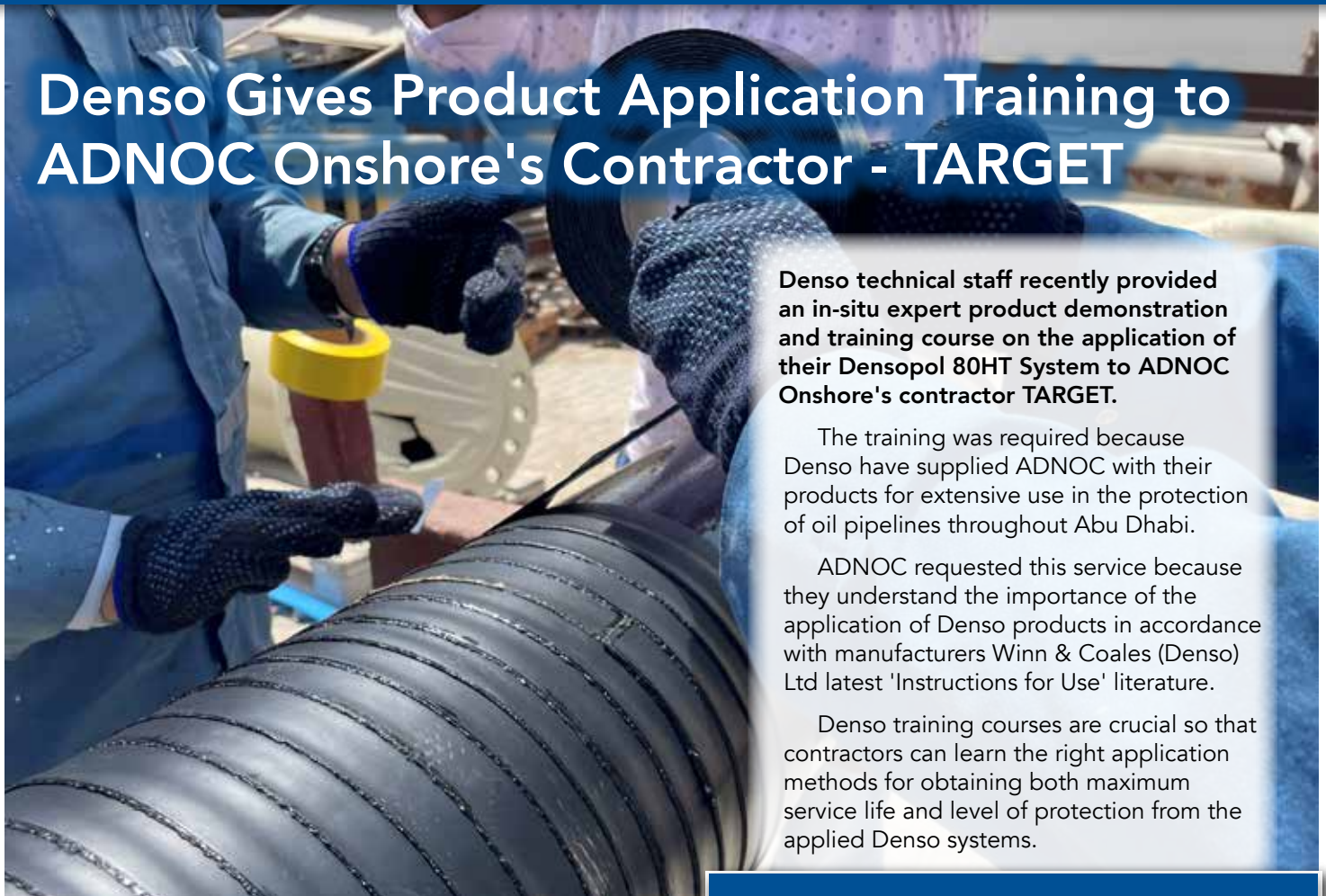
Above: DensoPol 80HT™ is applied over Denso Primer D™.
